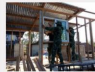
19 ตุลาคม 2019 สร้างกำแพงบ้านใหม่ ผู้บันทึก: นางกัญญา ไบทอง
